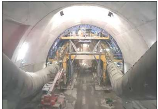
Scavi nel tunnel dei Giovi Elfosado de la tunelo
