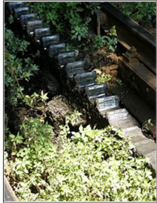
Cremagliera Strub sulla Catanzaro-Sala Dentorelo Strub sur la Catanzaro-Sala
