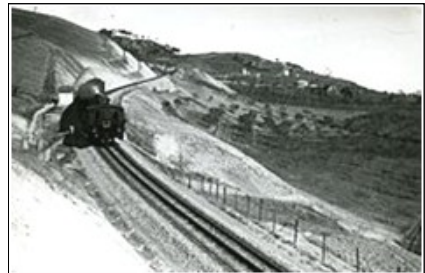
1912 circa - Treno in transito sulla ferrovia a cremagliera Saline-Volterra (sistema Strub) 1912 ĉirkaŭ - Trairanta trajno sur la dentrela vojpeco Saline-Volterra (Strub-sistemo)
