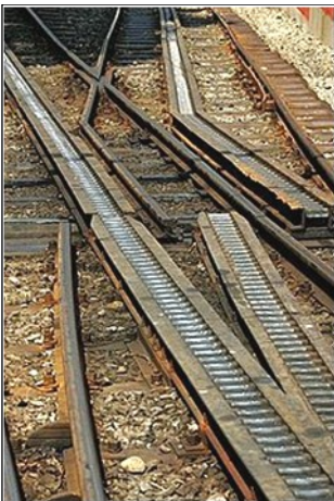
Scambio su linea con cremagliera sistema Riggenbach Trakforko sur dentrela linio je Riggenbach-sistemo
