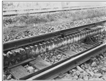
Particolare dell'innesto della cremagliera Strub sulla Saline-Volterra Detalo pri la enmetiĝo je la denterela vojpeco Saline-Volterra
