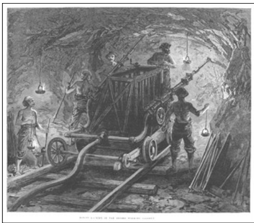
Incisione 1869 Foto. Operai al lavoro.
