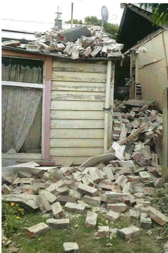
La brika muro forfalas de la domo de mia najbaro sur mian tegmenton, gazonon kaj fenestrojn.
