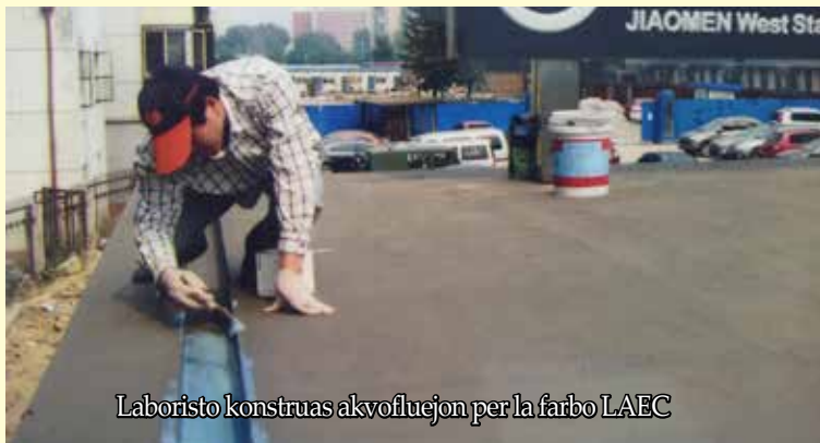
Konstruado de ŝtala tegmento per la farbo LEAC
