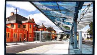
nova moderna terminalo en Česká Třebová
