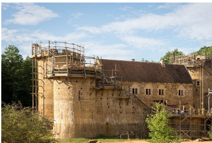
Fig 16: La kastelo vidata de malantaŭe. Observu la 4 fenestrojn.
