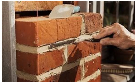
Plenigo de horizontalaj juntoj: Bildo 17: Uzo de junto-fero
