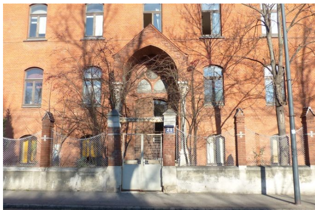
Foto 2a: Fasado de la domo kun ĝia pordego-ŝirmilo. Notindas la kurbaj linteloj.
