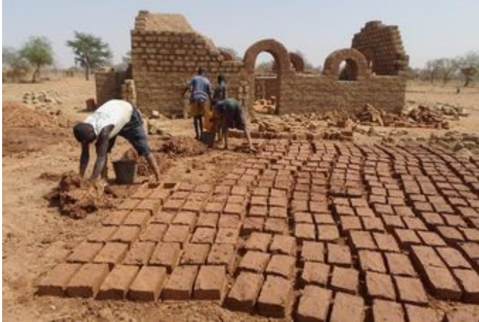
Bildo 5: Laboristoj fabrikas brikojn el banko (adobojn) per muldiloj. (Segenega, en Burkina Faso)
