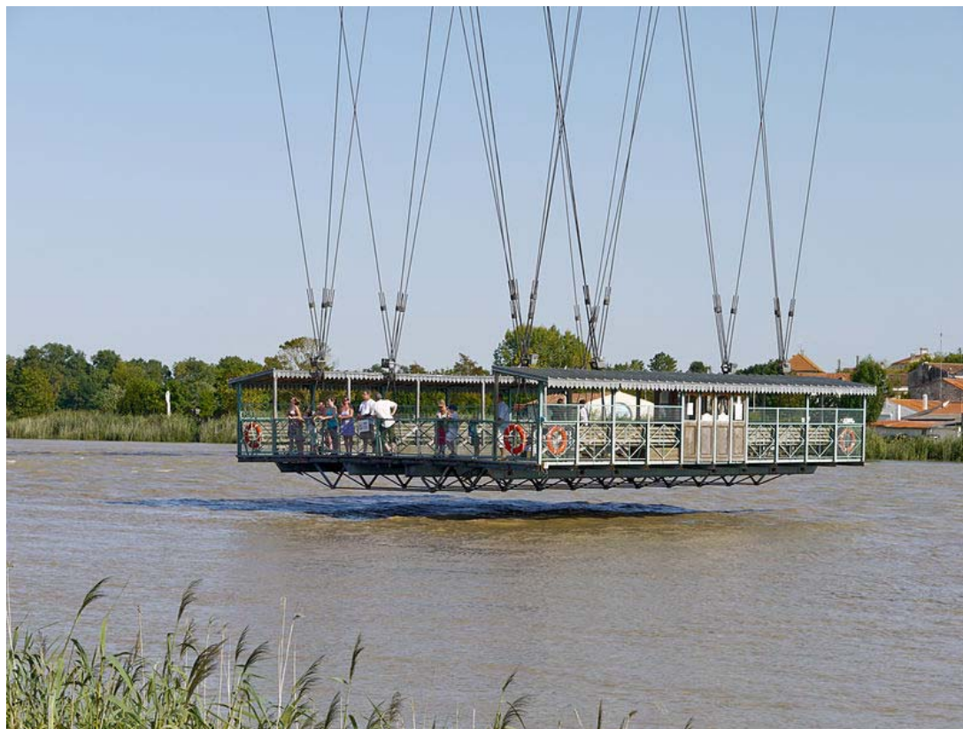
Foto 3 : La transborda platego, pendanta sur la supra spano per ŝtalaj ŝnuregoj, trairas la riveron
