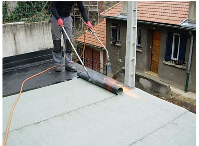
Foto 9: Flam-glui bendojn (dekstre)
