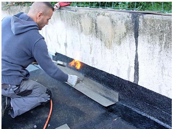
Foto 8: Plisekurigo de la anguloj per bendoj el armita asfalto.
