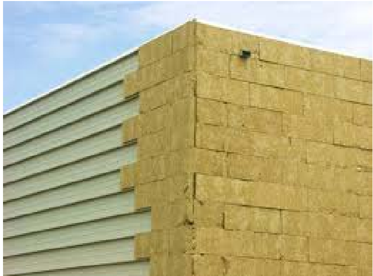
Foto 2: Izolado antaŭ tegado
