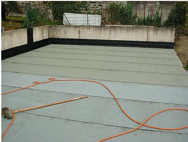
Foto 9: Flam-glui bendojn (dekstre)
