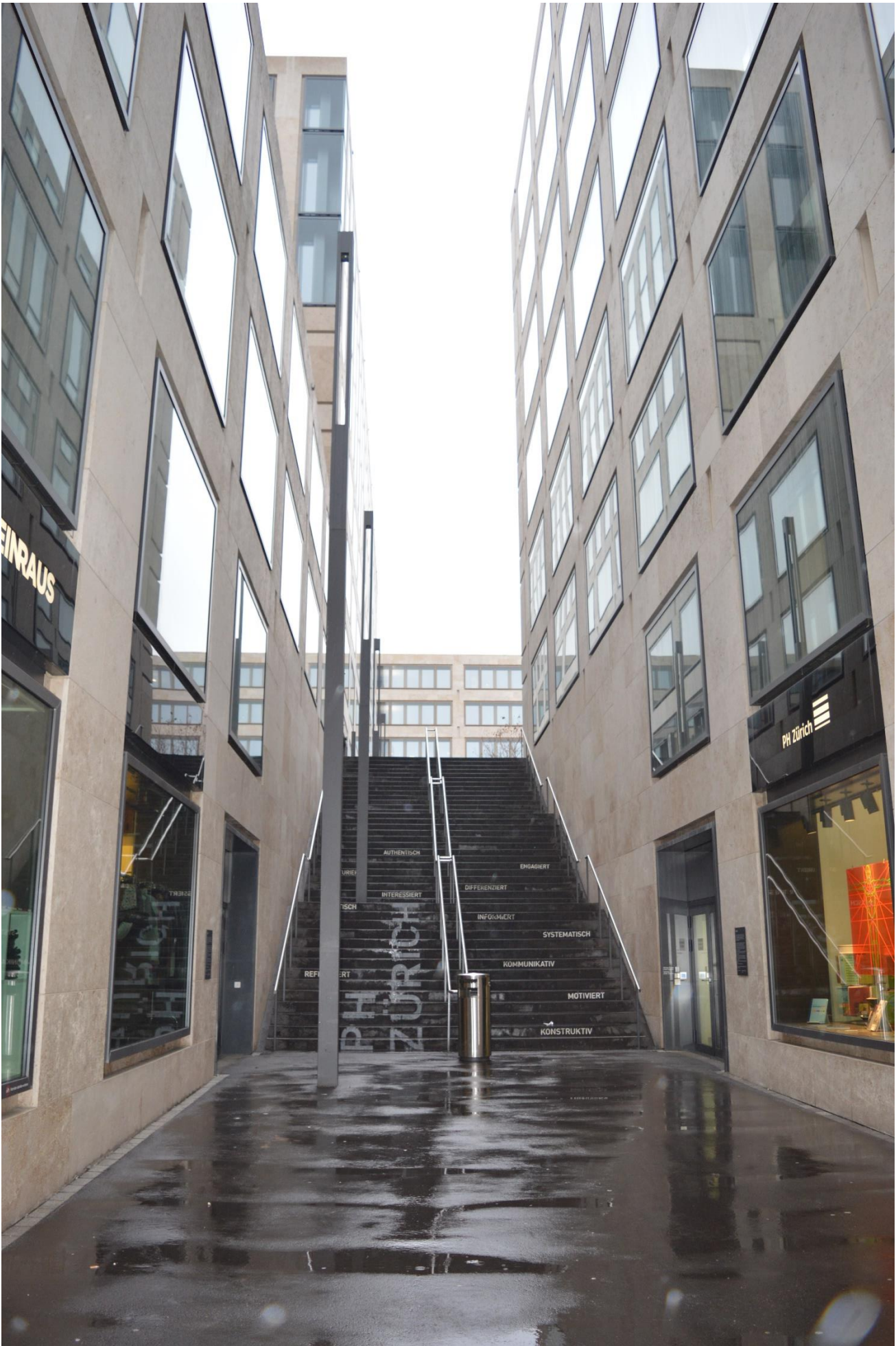
Pädagogische Hochschule Zürich: Beispiel eines Minergie-Gebäudekomplexes Pedagogia Altlernejo Zuriko: Ekzemplo de minergia konstruokomplekso
