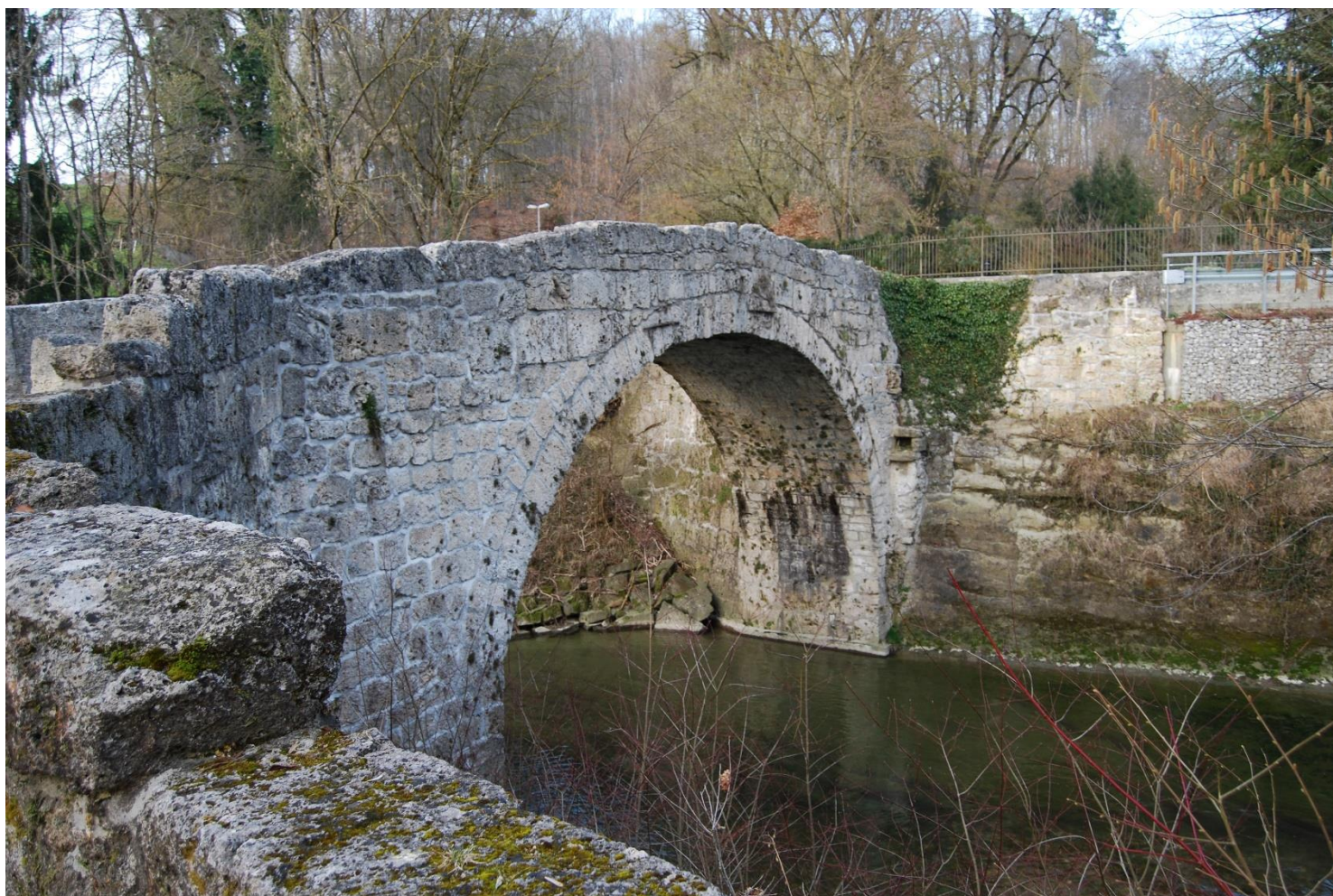
Die Brücke über den Röstigraben bei Villars-sur-Glâne – La Ponto trans la Roŝtifoso
