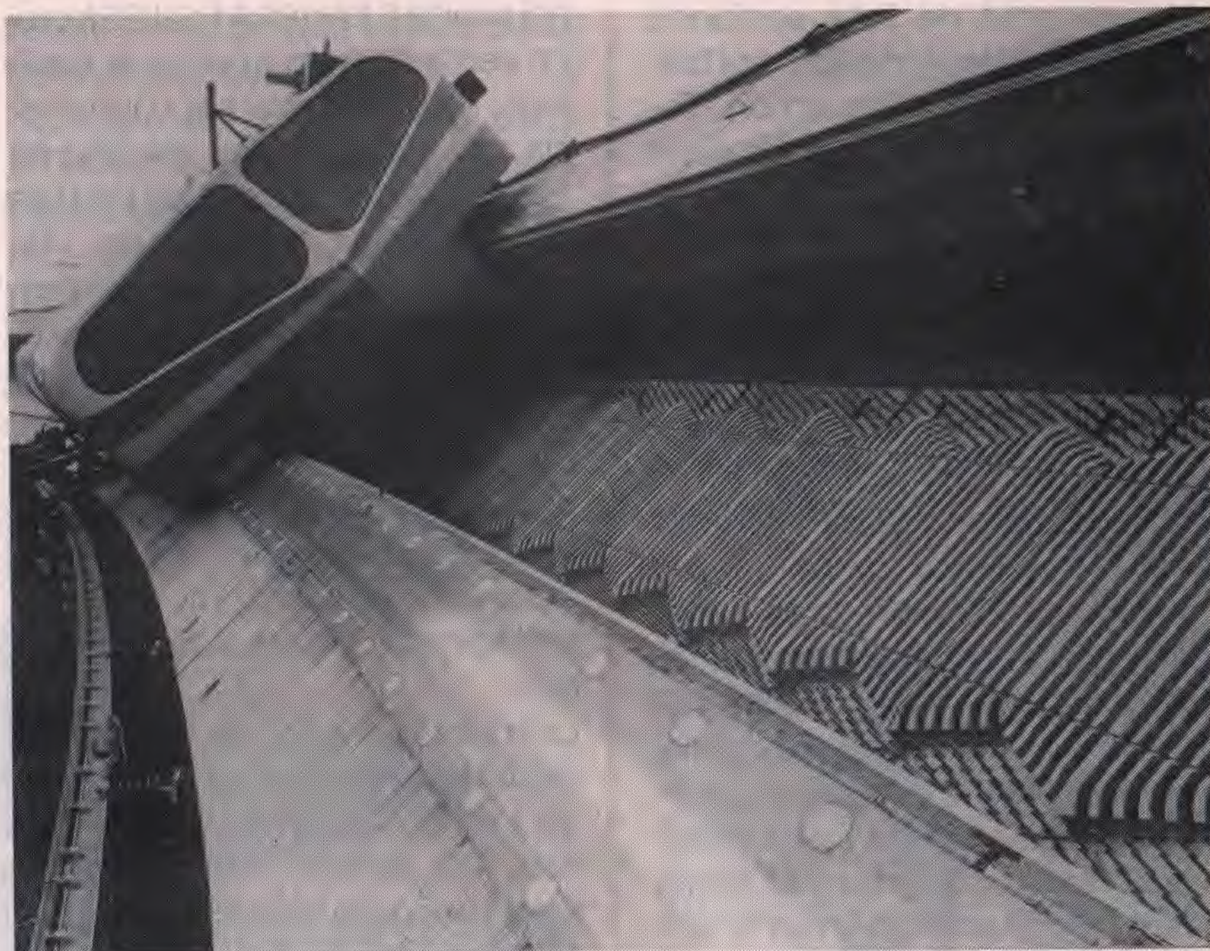
Koloso kun 17 tunoj: ĉiu tiu magneta ŝveb-veturilo sur betona vojo povos aviadil-rapidae veturi, nome 500 km/horo
