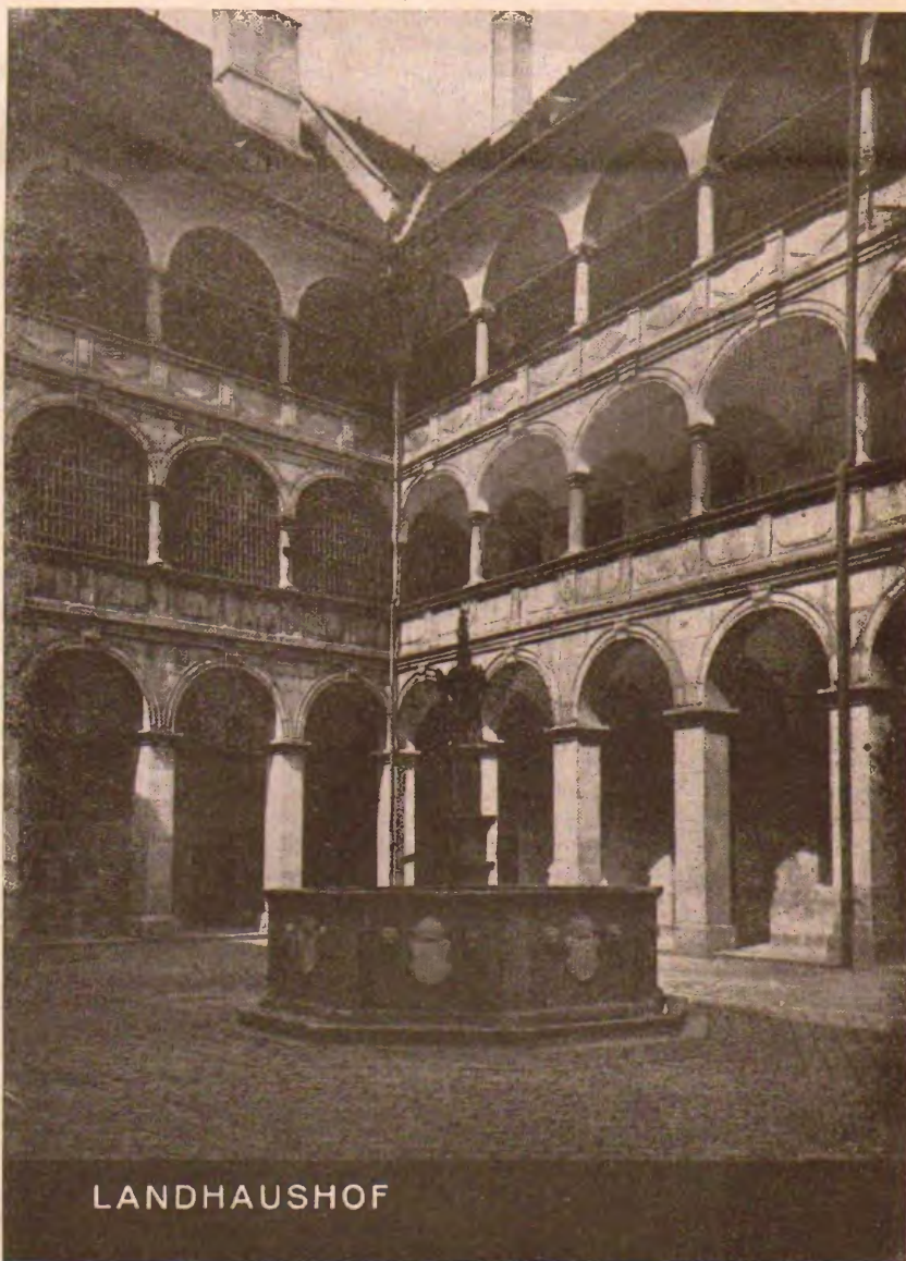
Unu de la multnombraj arkadaj kortoj en Linz-aj malnovaj burĝaj domoj. Tiu bildo montras la arkadan korton en Landhaus
