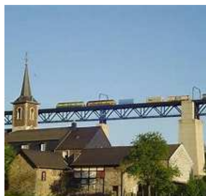
Viadukto de Moresnet
