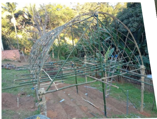
Strukturo fortika kaj malpeza danke al la flekseblo de fenditaj bambuoj
