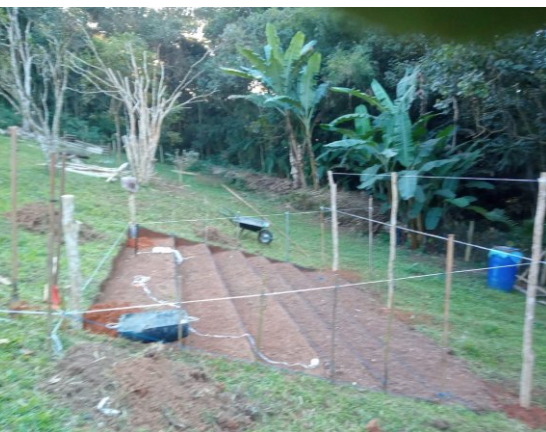
Grunda bazo de la forcejo mezuranta 20m 2 kaj fosita laŭ terŝtupoj.
