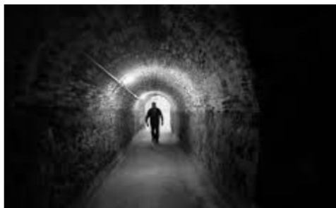
Kontraŭ-avia ŝirmejo en Villanueva de Córdoba, konstruita dum la civila milito
