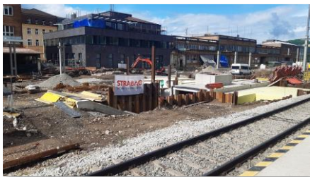
La stacio de Žilina entute estas konstruejo. Der Bahnhof von Žilina ist insgesamt eine Baustelle.
