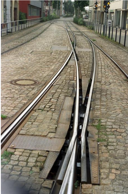
Trakinterplektaĵo apud la haltejo Zwickau Zentrum ligas la metroŝpuran tramtrakon al la normalŝpura fervoja trako.
