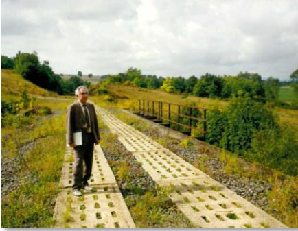
Spuro de riparlaboroj ĉe limproksima ponto Spuren von Reparaturarbeiten an einer grenznahen Brücke (foto: Walter Ullmann)
