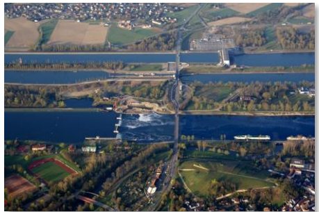
Hodiaŭ stratponto kuŝas sur la fundamentoj de la fervoja ponto. Heute liegt eine Straßenbrücke auf den Fundamenten der Eisenbahnbrücke. (Foto: Luftfahrer, WikiMedia)
