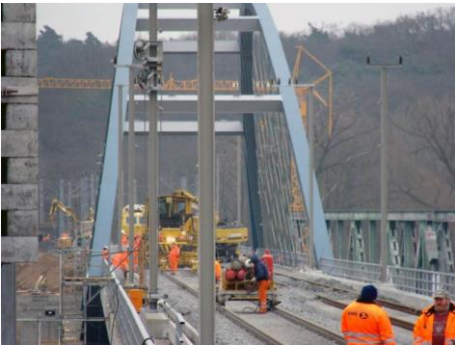
Trans la nova ponto estas metata la ŝotrobalastaj trakoj. Über die neue Brücke werden die Gleise im Schotterbett verlegt. (Foto: Eisenbahnfreunde Frankfurt (Oder))
