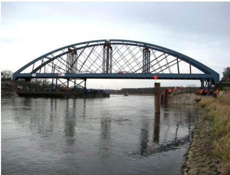
Pontona lokado de la nova arkoponto Platzieren der neuen Bogenbrücke mit Pontons (Foto: Eisenbahnfreunde Frankfurt (Oder))
