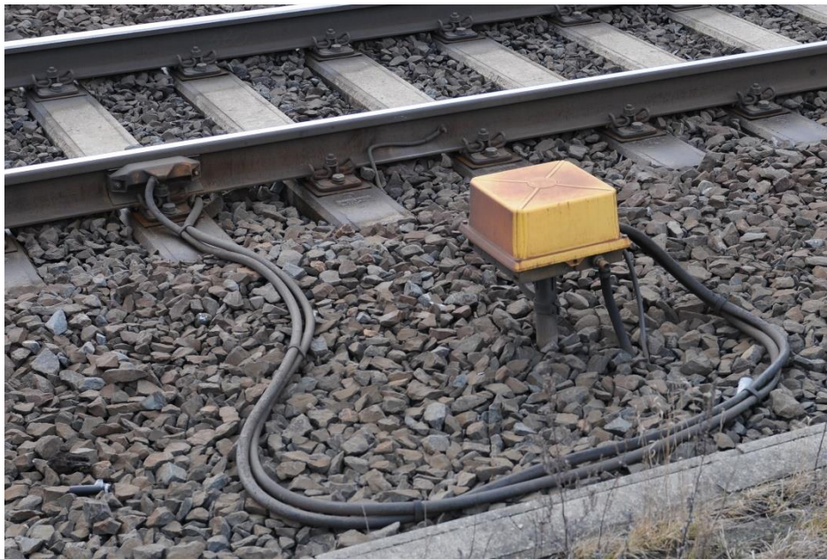
Achsnombriiloj estas eblaj elementoj de aŭtomata liberkontrolaj sistemoj. Achsähler sind mögliche Bestandteile selbsttätiger Gleisfreimeldeanlagen. (Foto: Gruppentaste WikiMedia)
