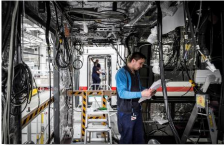
En Krefeld estas muntataj la energiaj kaj informaj kabloj. In Krefeld werden die Versorgungs- und Nachrichtenkabel montiert. (Foto: DB-Mediathek)
