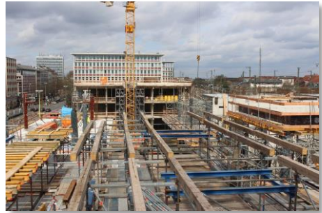
Sur la apogaj traboj estu konstruata la tegmento de le enira halo. Auf den Stützbalken soll das Dach der Eingangshalle gebaut werden. (Foto: DB Mediathek)
