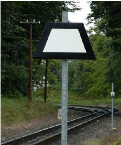
Sur trajngvida (?) linio la tabulo Ne1 anstataŭas eniran signalilon. Auf einer Zugleitstrecke ersetzt die Ne1-Tafel das Einfahrsignal.
