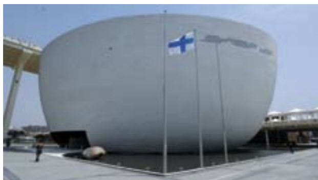
Muroj de la Finna Pavilono estas el kunmetitaj konstruaj materialoj nov-tipaj. Ili, malmolaj, frotorezistaj, malpezaj kaj senkoloriĝaj, estas facile malmunteblaj kaj reutiligeblaj
