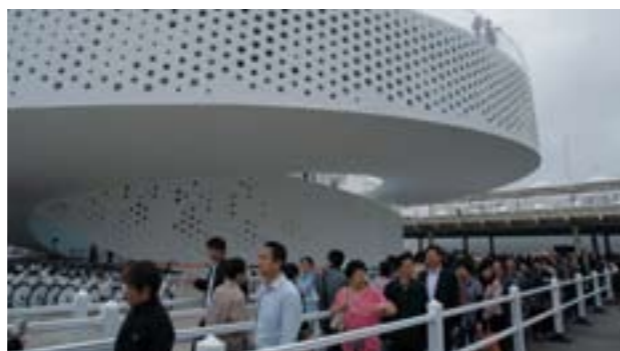
La eksteraj muroj de la Danlanda Pavilono estas plenaj de truoj, kiuj faciligas ventumadon kaj kondukas la sunlumon en la pavilonon, kaj nokte la lampolumoj trairas tiujn truojn por prilumado
