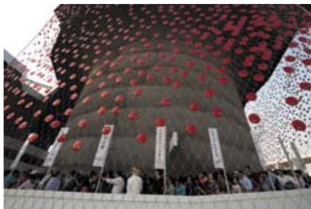
La ekstera muro de la Svisa Pavilono estas el sojfabo-fibro, kiu povas produkti elektron kaj malkomponiĝi en naturo
