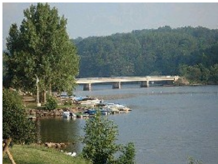
Barrage de Rabodanges
