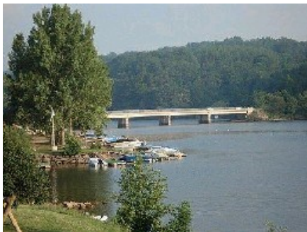
Barrage de Rabodanges
