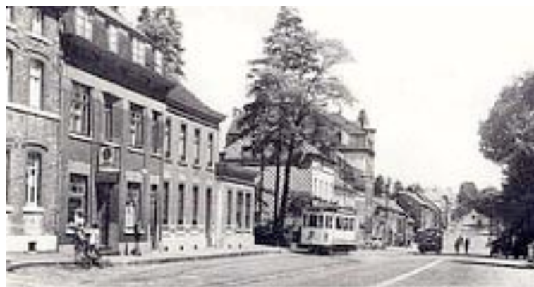
Tramo en Kelmis
