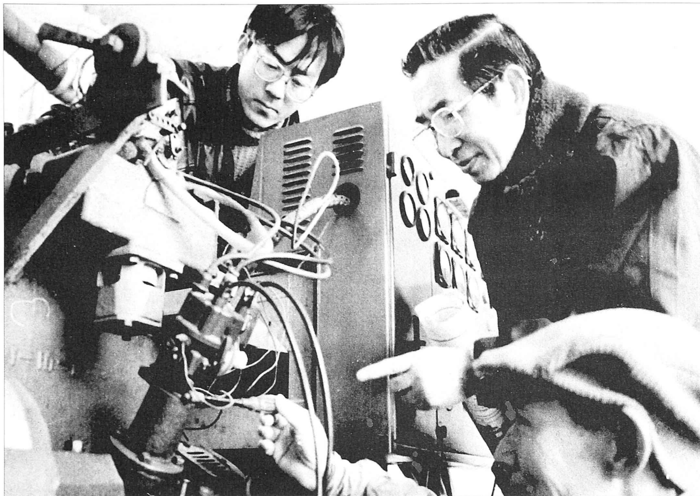
Alt-efika motoro funkciigata de metano farita de Zhejiang-universitato
