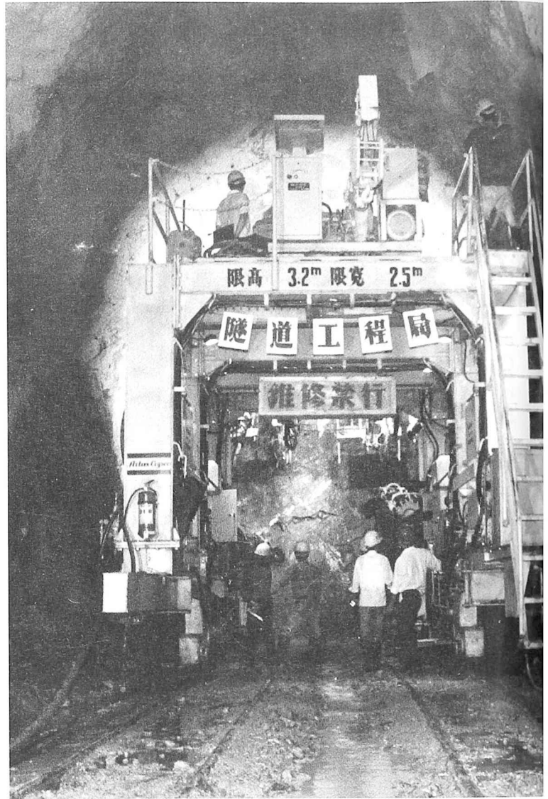
Konstruado de tunelo Foto de ZHOU MINZHONG
