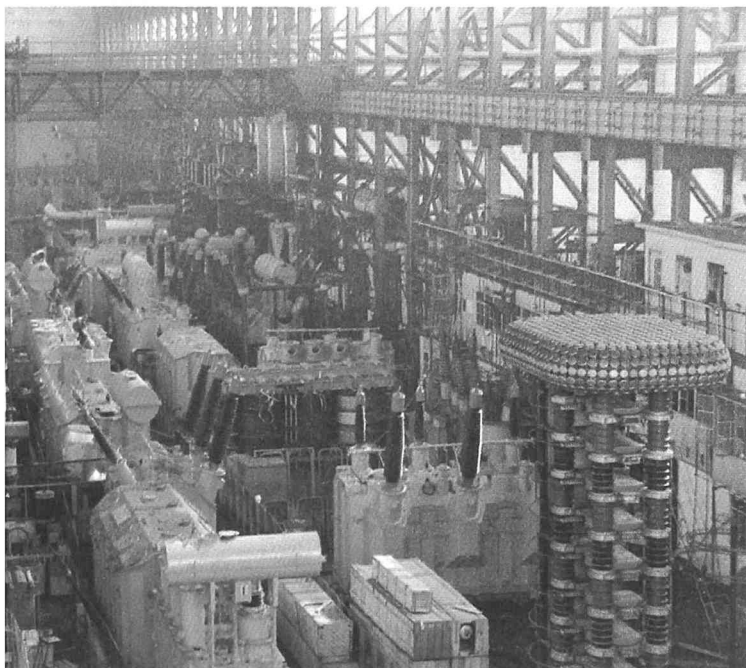
En la Transformatora Fabriko de Shenyang
