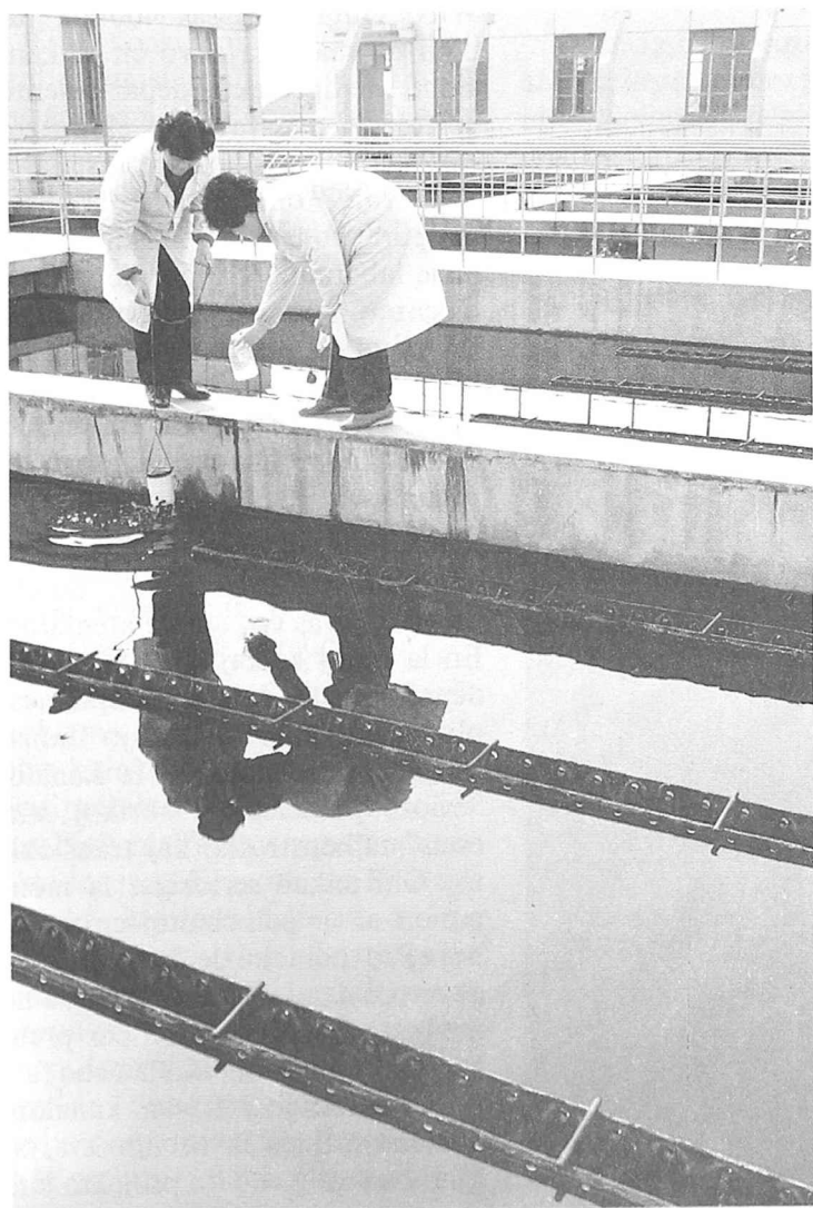
Instalaĵo por trakti malpuran akvon en Changzhou
