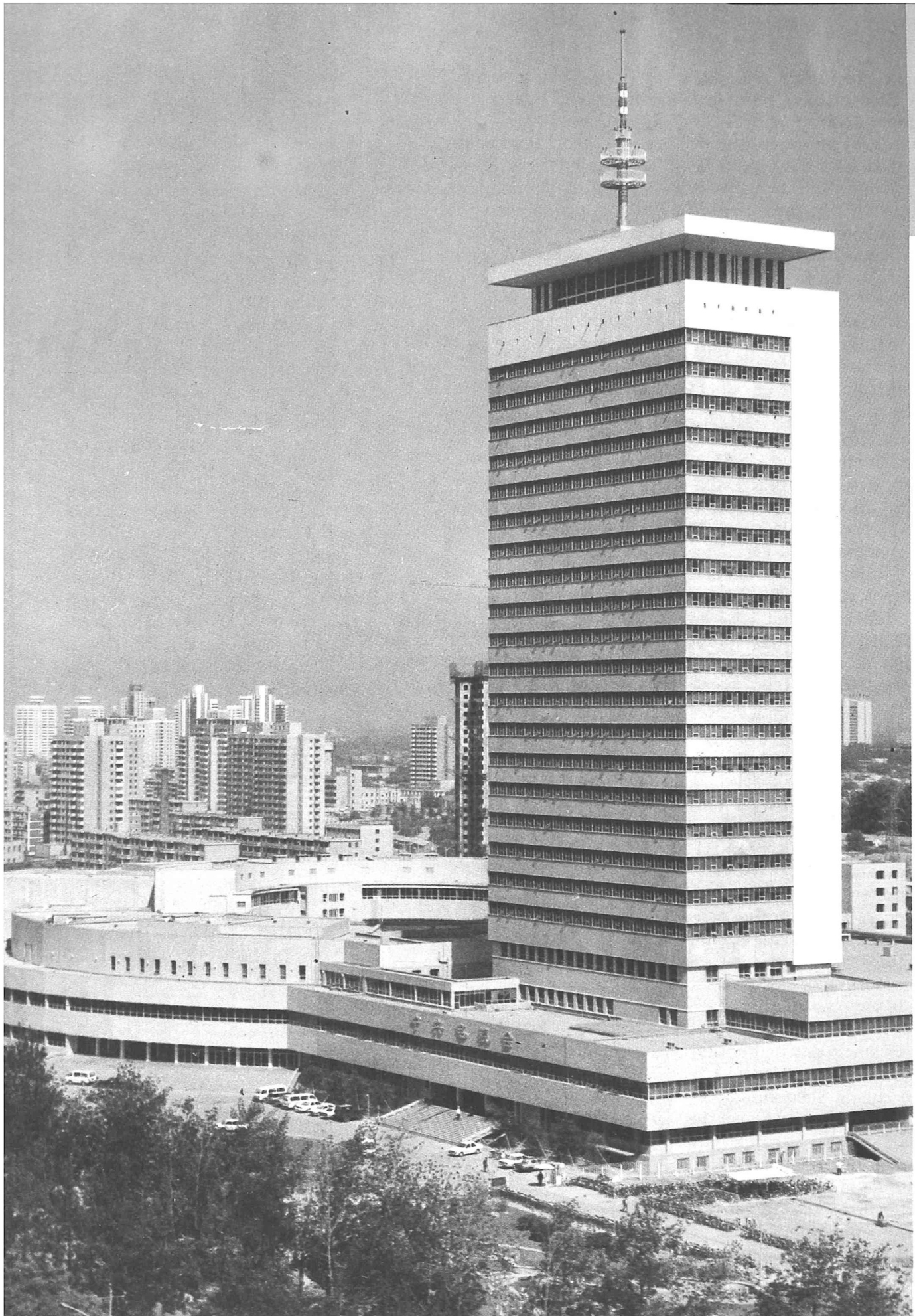
Ĉina Televido. La domo altas 130.5 metrojn, senegaia en Pekino. Ĝia totala areo estas 80 000 kvadrataj metroj kaj en ĝi funkcias 19 studioj.
