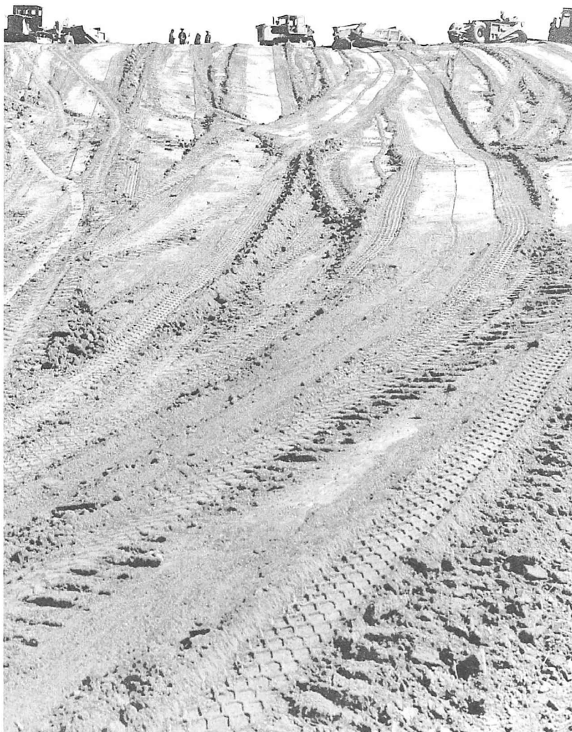
Ĉanghong-strato al la pontego en konstruado
