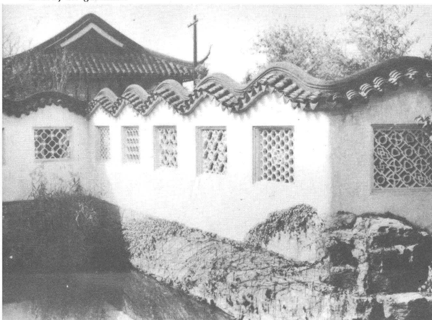
Muroj en ĝardeno
