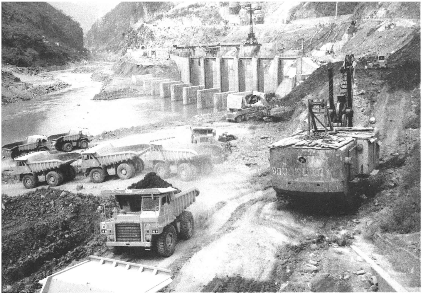
La konstruata hidroelektrejo Tjanŝengĉjaŭ, kiu povos produkti 13.45 miliardojn da kilovatthorojn da elektro
