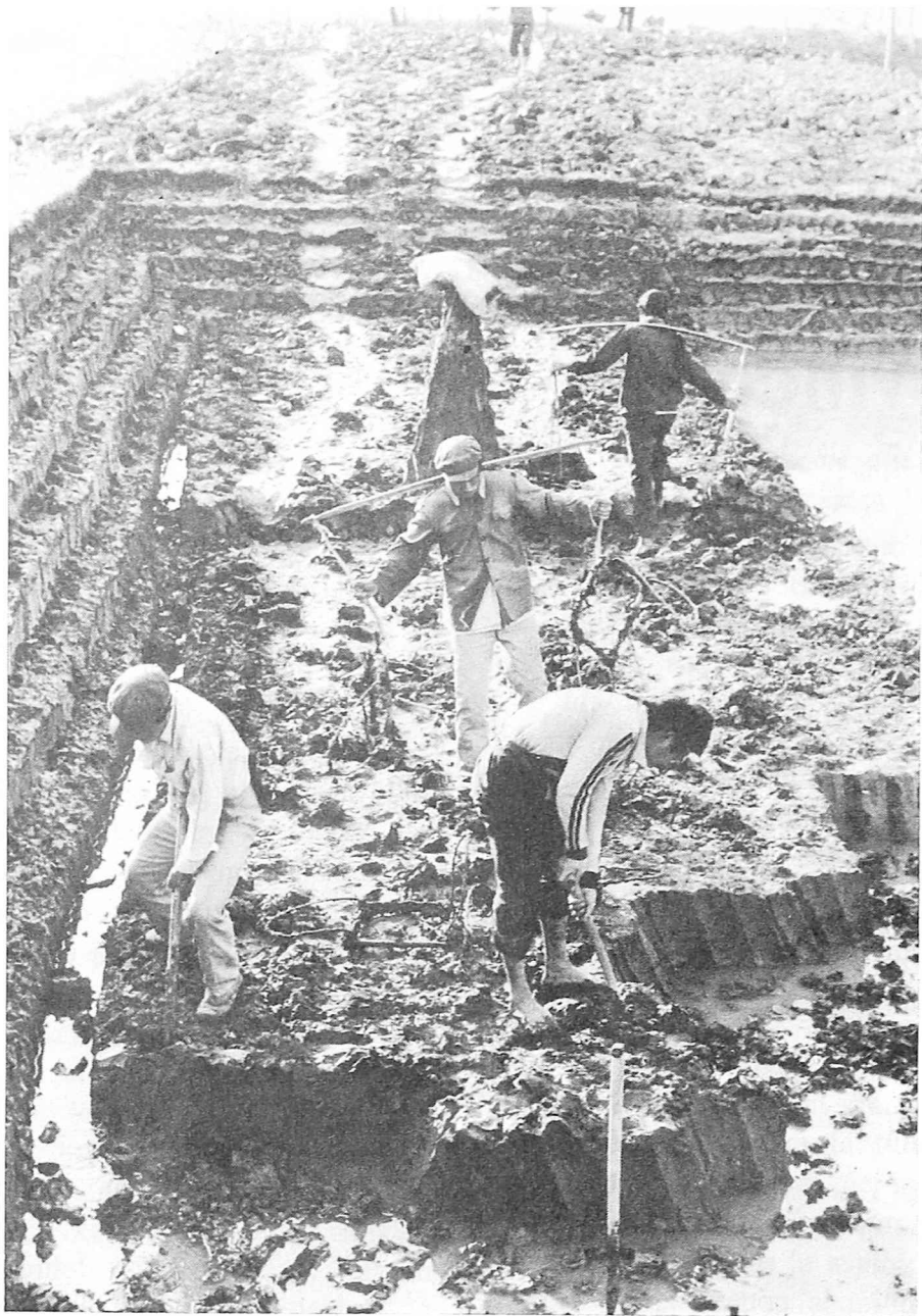
Konstruado de fiŝbaseno en marĉejo
