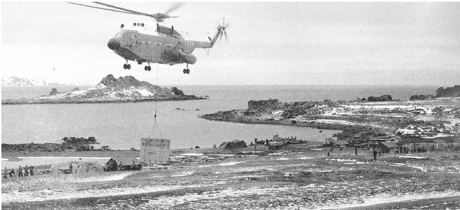
La ĉina stacio "Granda Muro" konstruata en Antarkto
