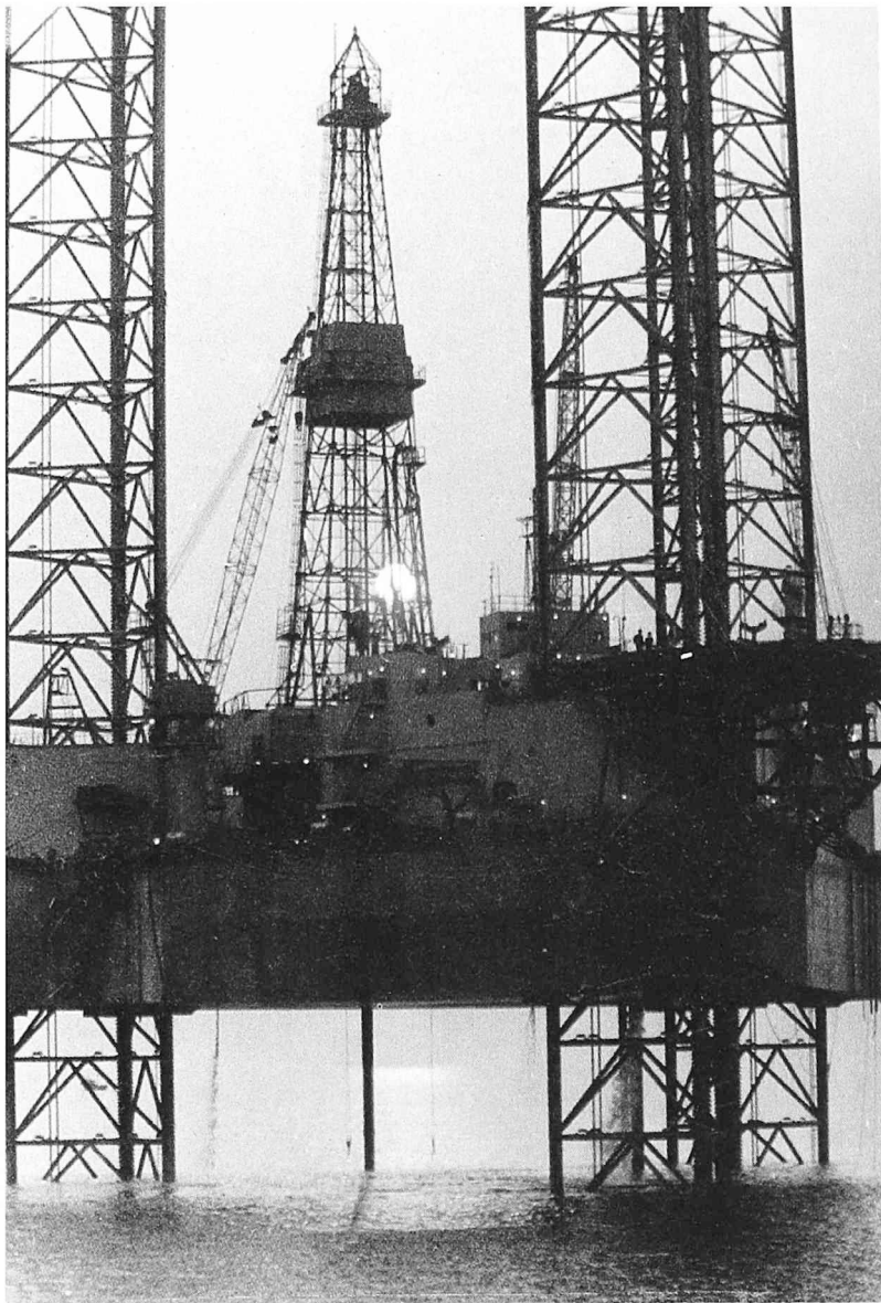
La putobora platformo "Nanhaj n-ro 3" en laboro
