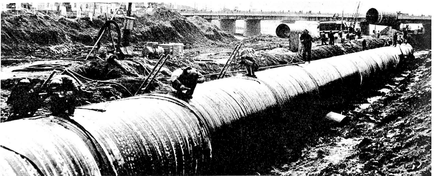
Por gardi akvon de polucio, oni instalas 14.5-kilometran subteran ŝtalan tubaron kun diametro de 2.5 metroj.
