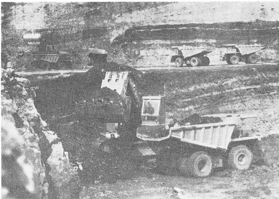
La Subĉiela Karbominejo Huolinhe en konstruado
