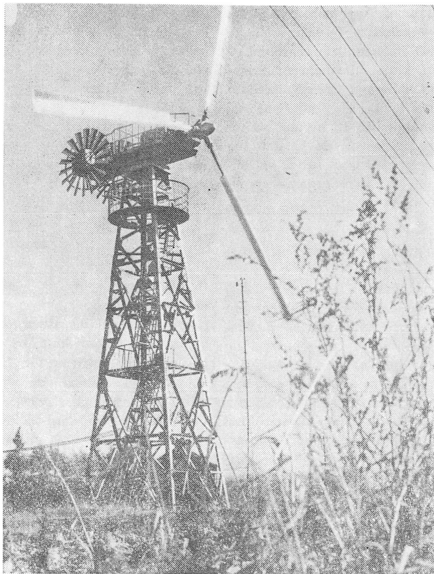
Ventoenergia generatoro kun kapacito de 20 kilovattoj, fabrikita de la Meĥanika Instituto de Heilongjiang-provinco
