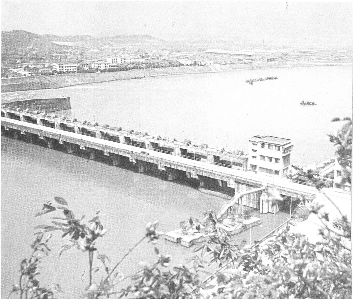
Barajo de la Fuchun-rivera Hidroelektrejo
