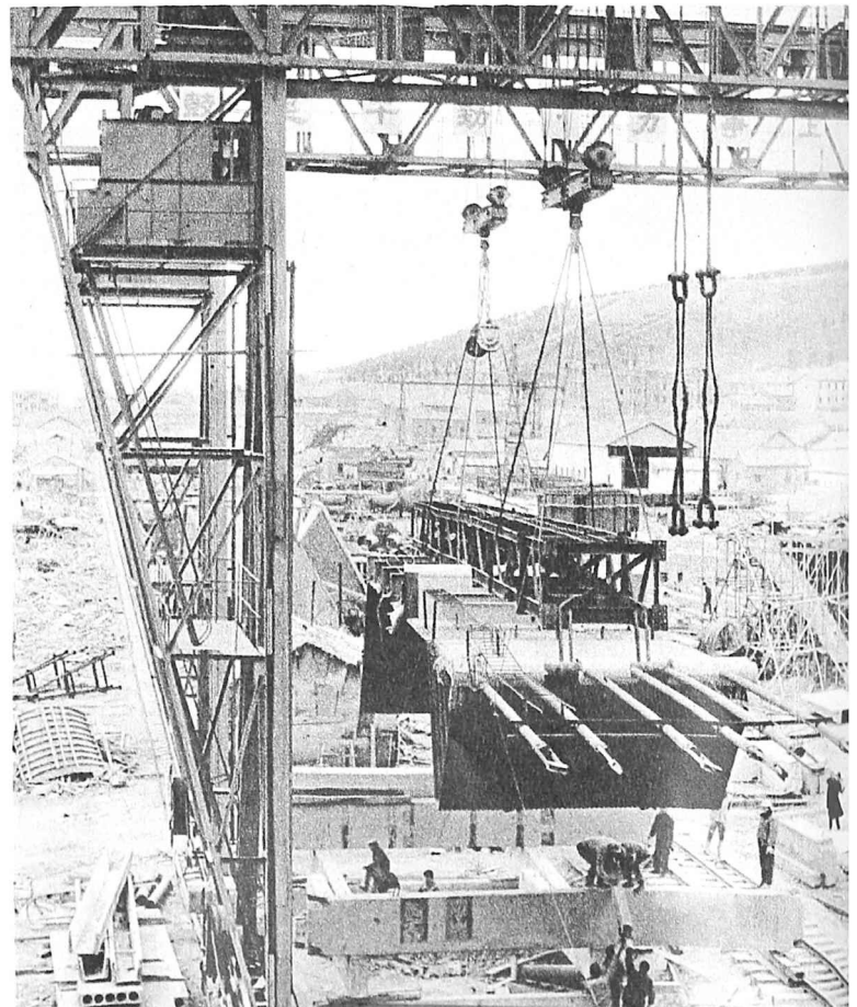
Transportado de la akvo-malvarmiga muro
