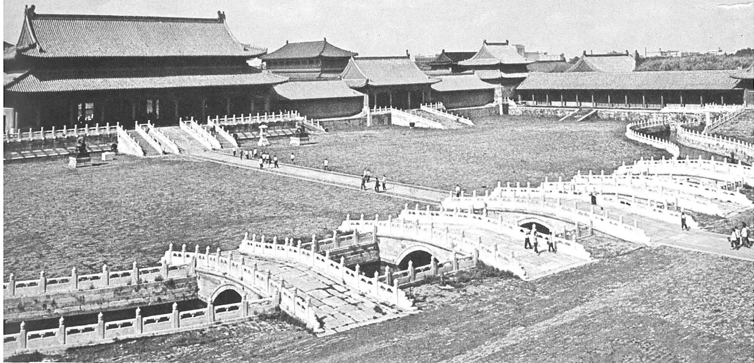
Tajhemena-pordego kaj Ginŝuj-pontoj
