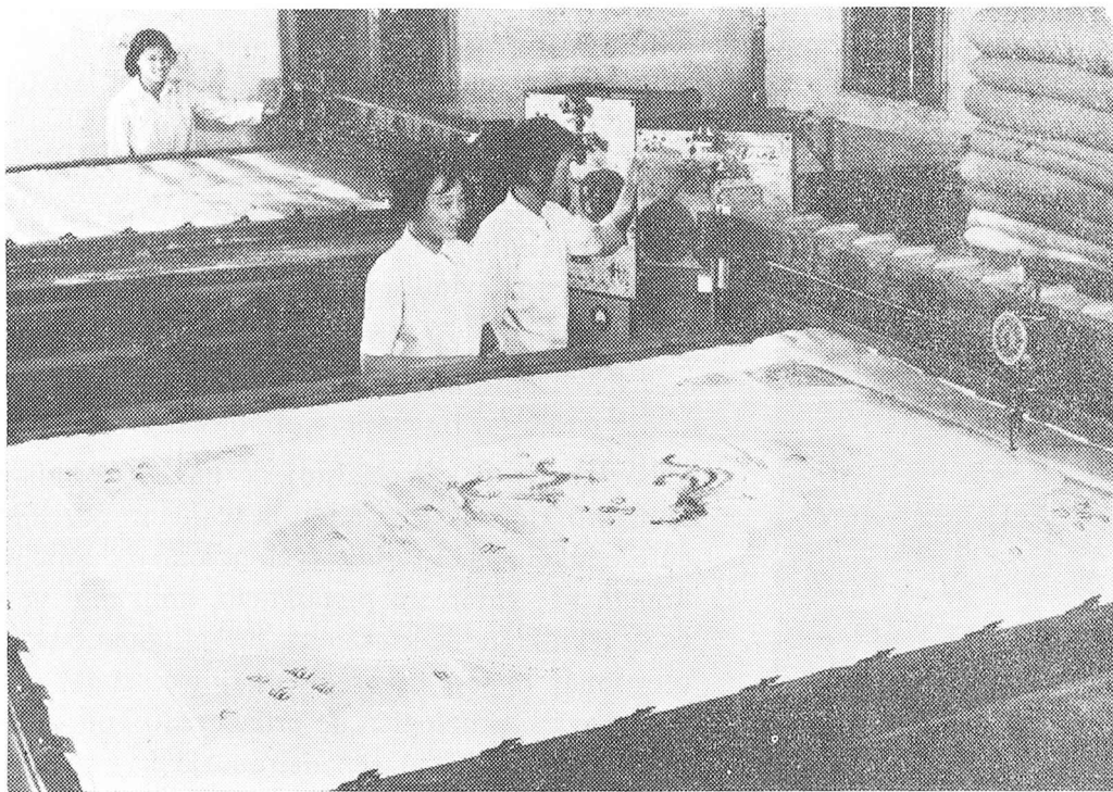
Brodmaŝinoj procede re-gataj per fotoelektra aparato
