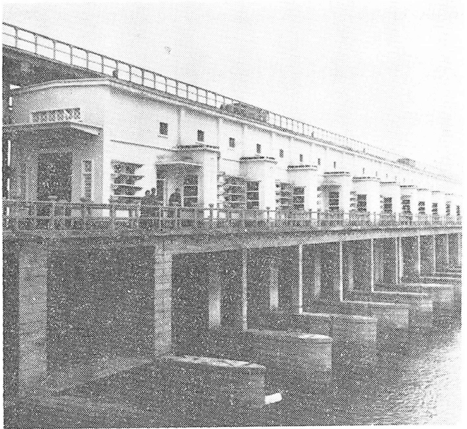
Hidroelektrejo kun kapacito de 5,000 kilovatoj konstruita de la Ŝunde-gubernia popolo ĉe rivero nur 0.3 metron profunda
