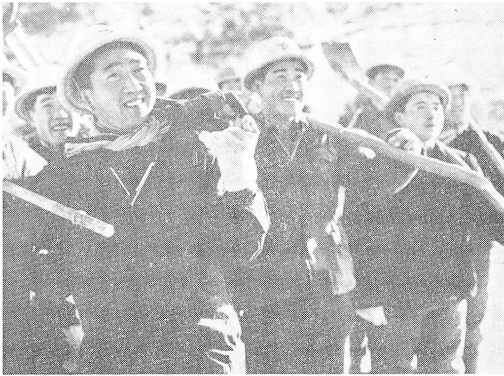
Konstruantoj de la plej granda akvoutiliga konstruaĵo en la tuta gubernio por konduki akvon de la okcidento orienten.
