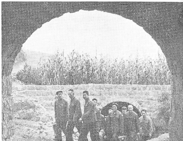
Siping-brigado konstruis en ravino subteran akvedukton por dreni pluvakvon kaj sur ĝi kreis multajn kampojn.
