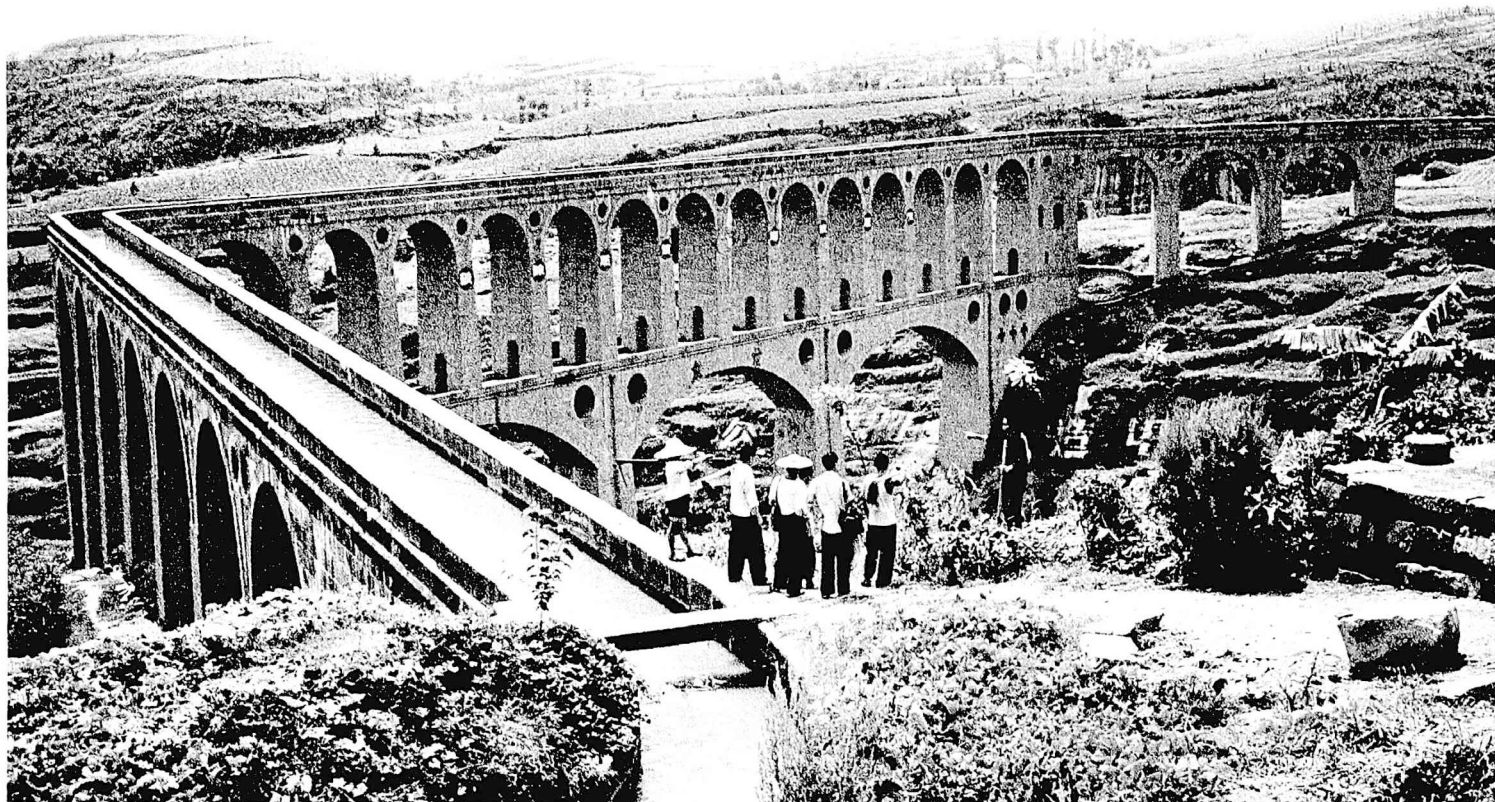
La akvedukto "Amikeco" longas je 272 metroj kaj altas je 41.7 metroj, kun supera tavolo kiel akvedukto kaj malsupera kiel trotuaro.
