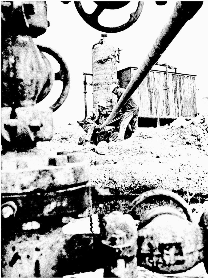
Instalo de flumetro
