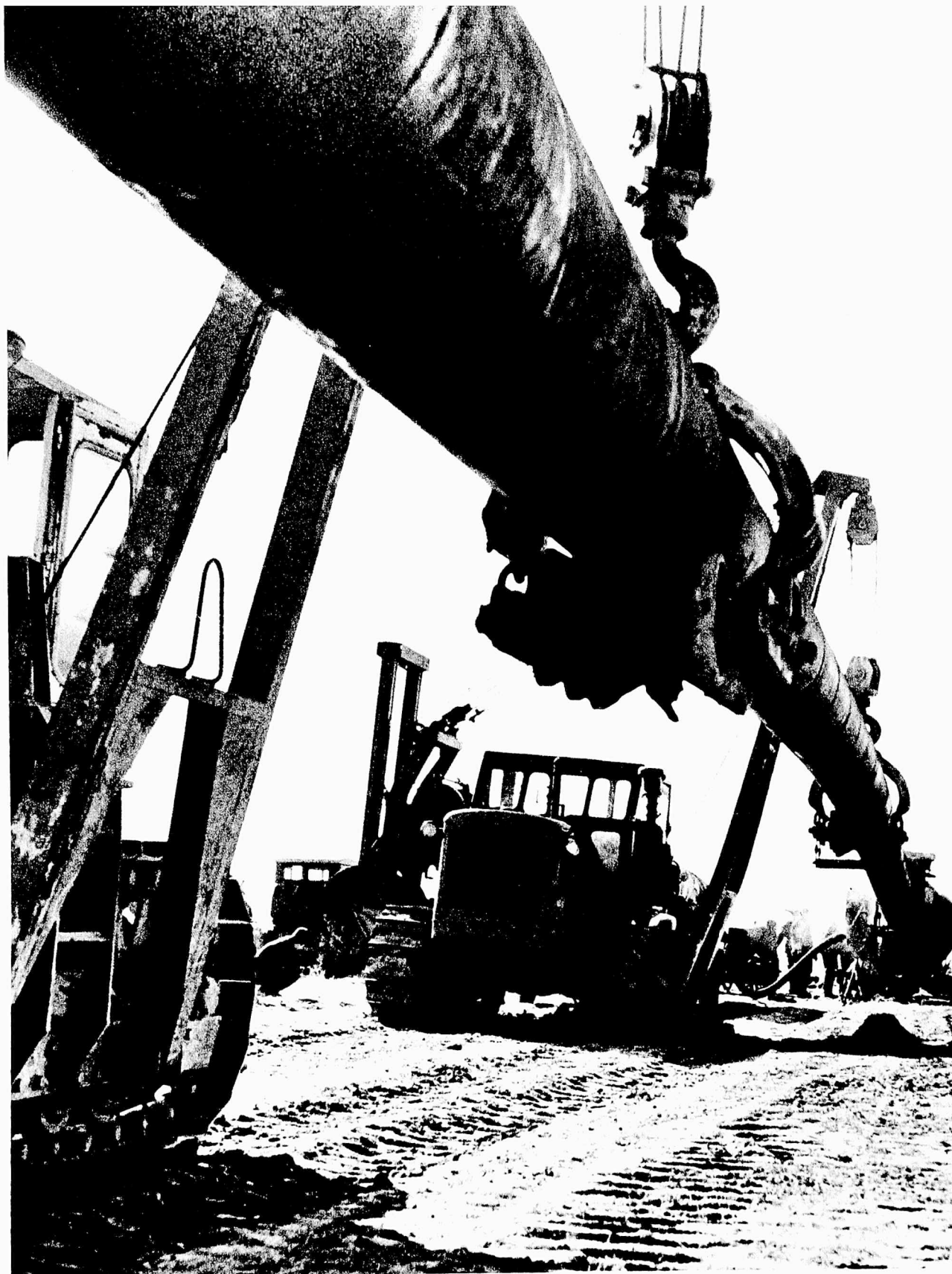
Instalado de oletuboj per maŝinoj projektitaj kaj fabrikitaj de Dagang-aj laboristoj mem
