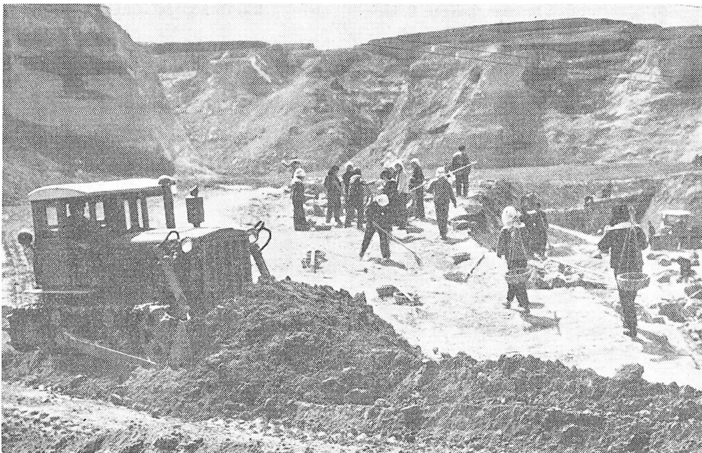
Konstruado de nova kampo per buldozo
