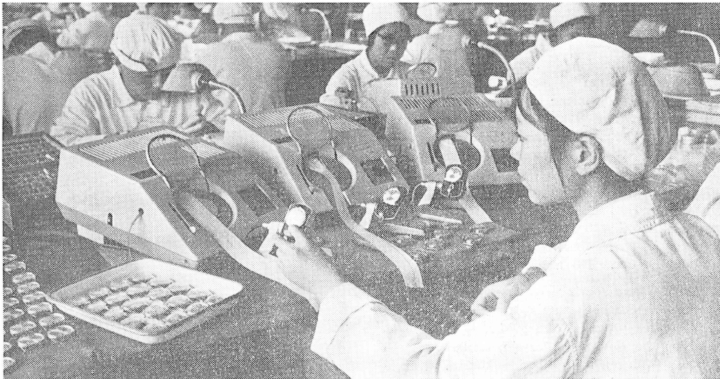
Laboristoj ekzamenas la kvaliton de brakhorloĝoj per aparatoj produktitaj de nia lando.
