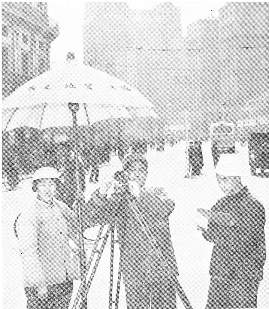
Ili faras mezuradon de la akva nivelo por esplori la grundo-leviĝon post enpumpado de akvo en tertavolojn en vitro.
