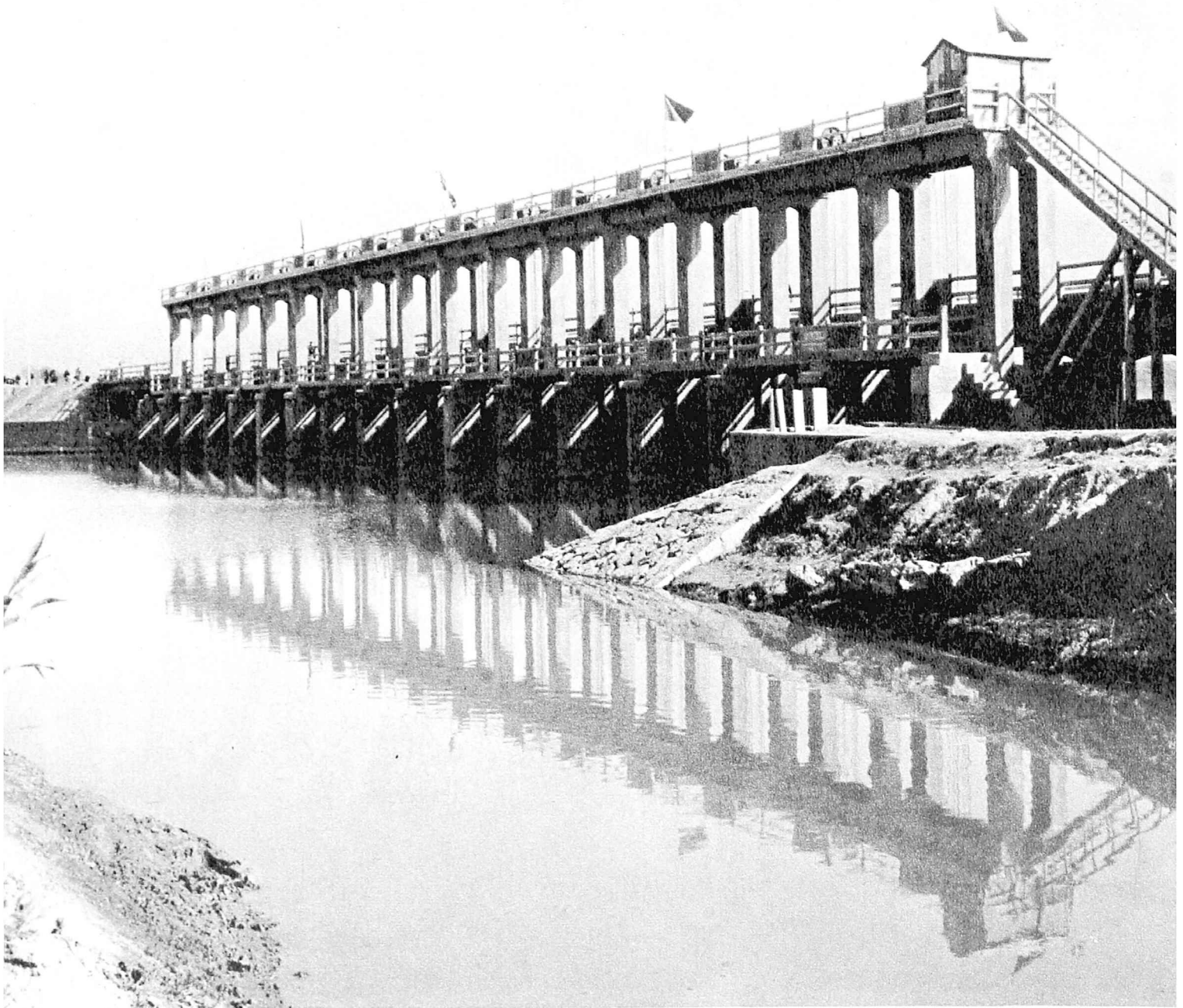
La popolo de Jongĉeng-gubernio de Henan-provinco konstruis akvutiligan sistemon por irigacio kaj dreno laŭlonge de Tuohe-rivero en la baseno de Huajhe-rivero. Ĉi tio estas Gangkiaŭ-kluzego sur Tuohe-rivero.
