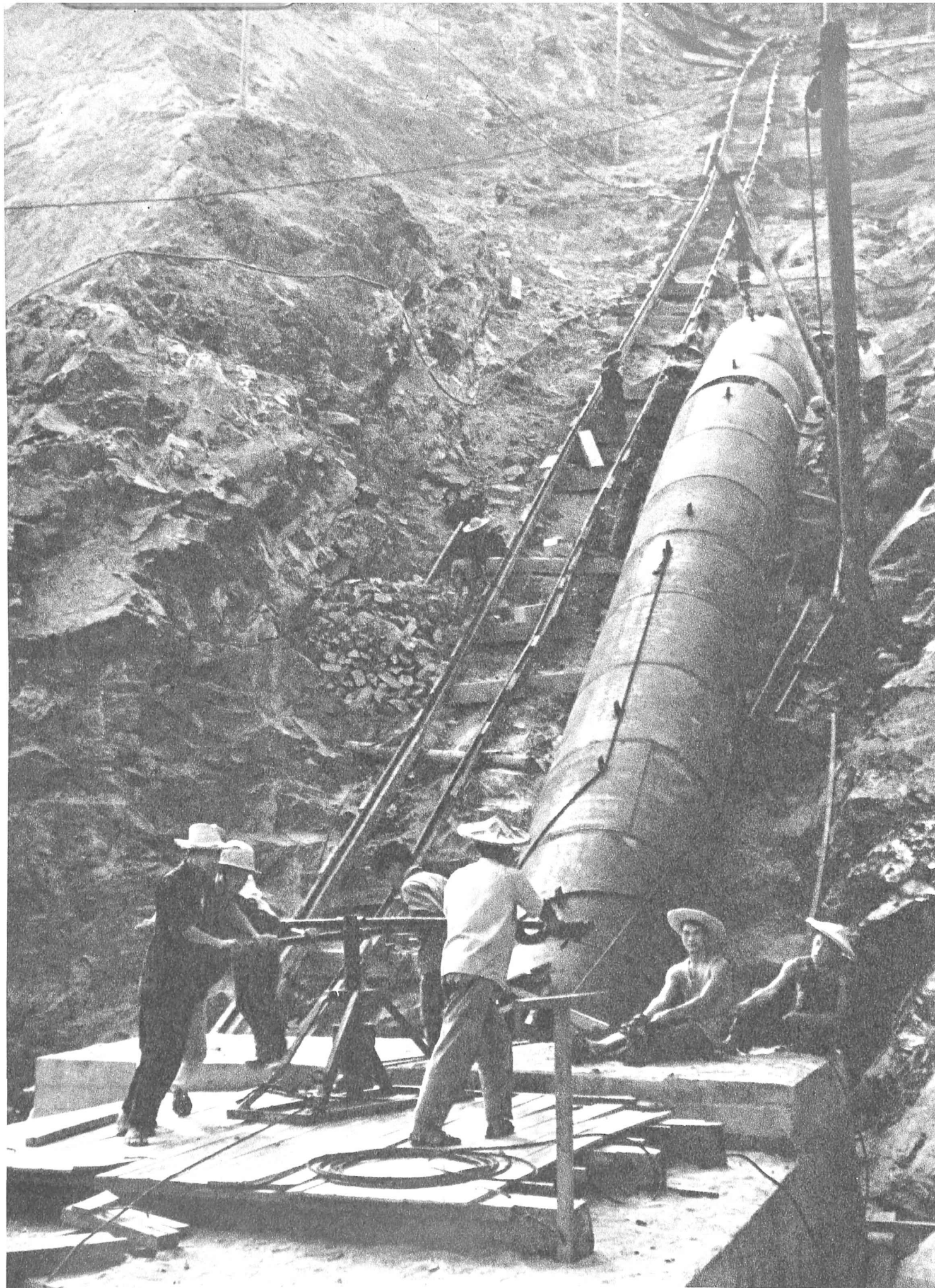
Aktiva konstruado de malgrandaj hidroelektraj de Jongĉun-gubernio de Fugian-provinco stimulas la disvolviĝon de agrikultura produkto. Jen komunumanoj instalas akvotubon por hidroelektra stacio.
